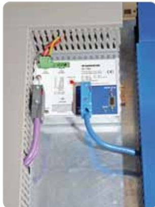
Obr. 6 Na iskrovo bezpečné oddelenie komunikačných zberníc RS485 a RS485-IS bol použitý segmentový prepojavací modul SC12Ex.
