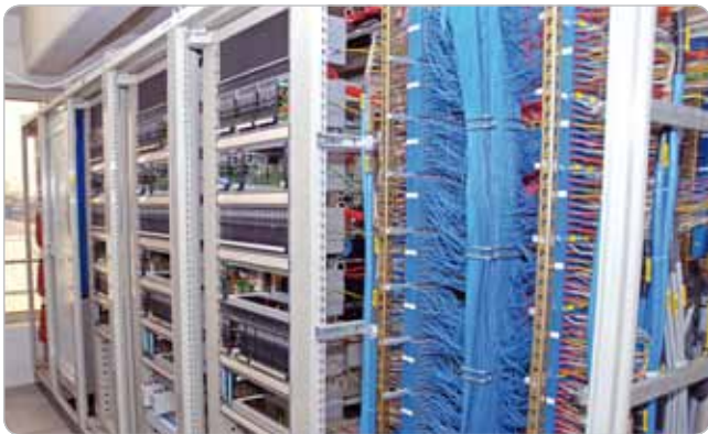
Obr. 4 Po modernizácii systému boli do 19" stojanov (v pozadí) nainštalované namiesto kariet rozhraní dva systémy excom.
