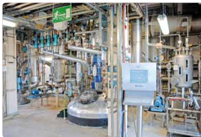
Obr. 2 V spoločnosti Elantas sa z reaktorovej linky posielajú množstvo analógových a binárnych signálov do kariet rozhraní a do systému excom a odtiaľ do riadiaceho systému.
