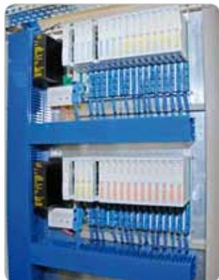
Obr. 5 EAB Automation nainštalovala nové systémy excom do 19" stojanov len za jeden víkend.
